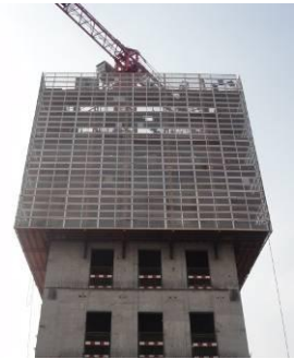
图 3.4-1 液压爬升模板外立面
