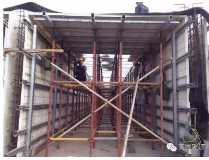
1 混凝土分两次浇筑的模板
