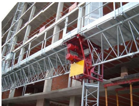
图 3.3 电动桥式脚手架
