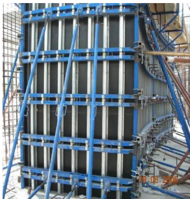
图 3.7-2 清水混凝土模板实例
