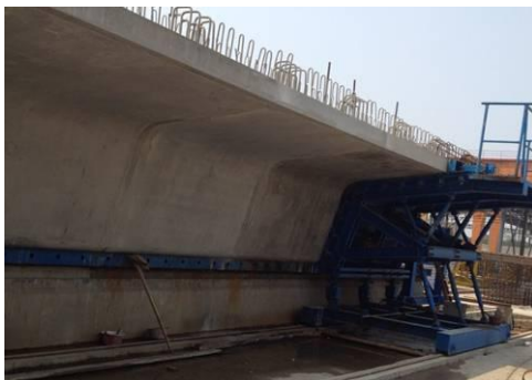
图 3.8-1 长线预制节段箱梁模板
