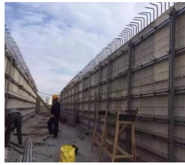
2 混凝土分三次浇筑的模板
