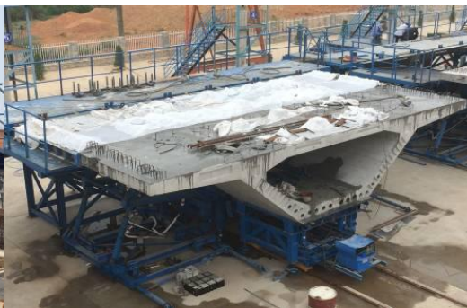
图 3.8-2 短线预制节段箱梁模板
