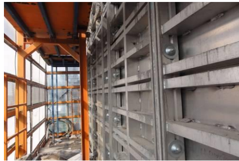
图 3.4-2 爬模模板及架体
